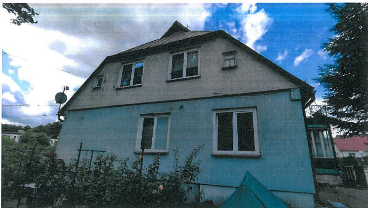
Fot. 2 – Widok - Elewacja wschodnia.
