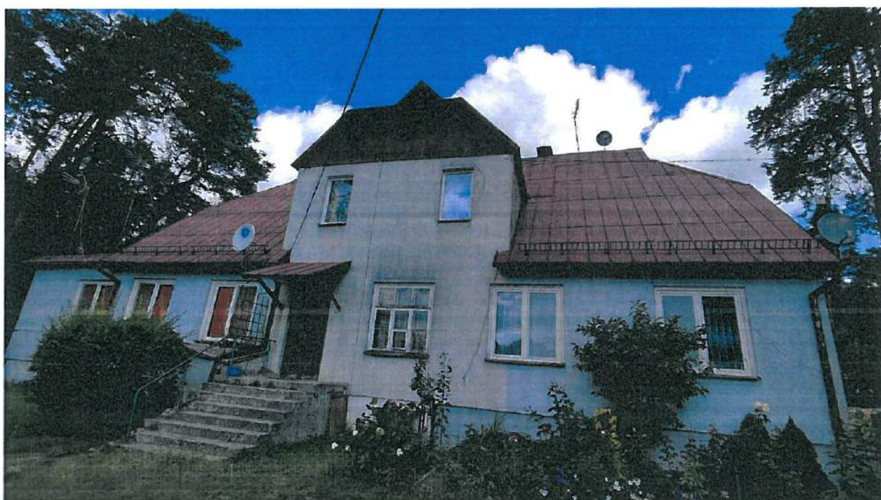
Fot. 3 – Widok - Elewacja południowa.
