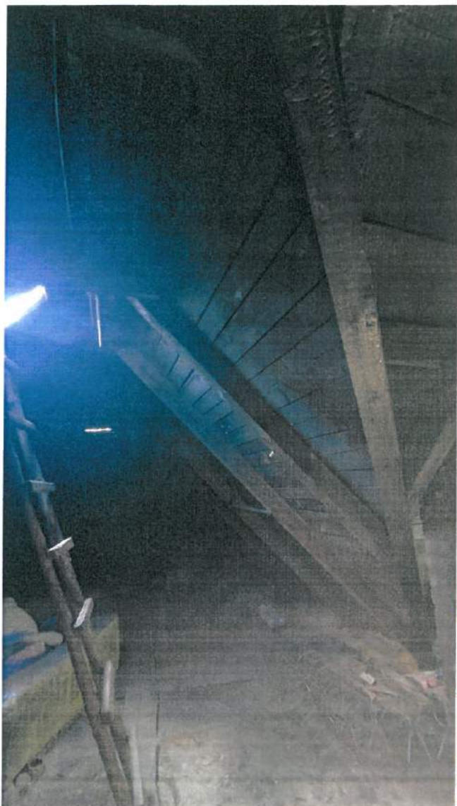
Fot. 15 – nadpalona oraz zadymiona pozostała część więźby. / Fot 16. Zalane docieplenie – polepa z trocin.
