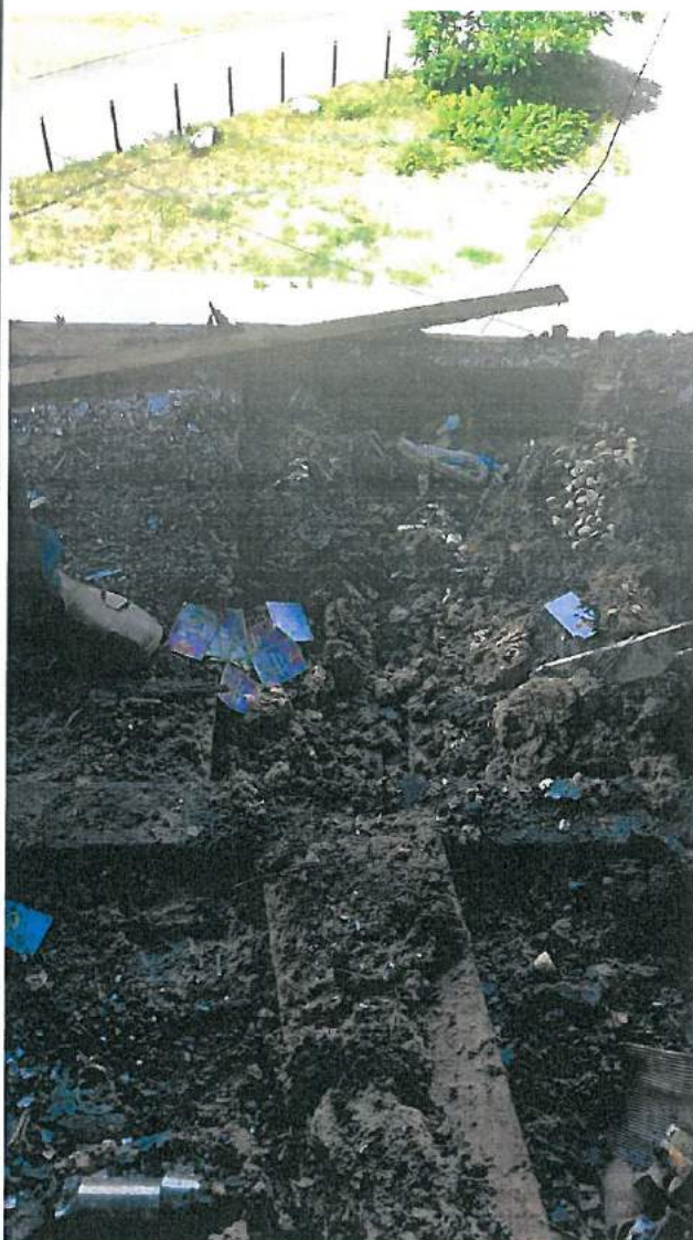
Fot. 15 – nadpalona oraz zadymiona pozostała część więźby. / Fot 16. Zalane docieplenie – polepa z trocin.
