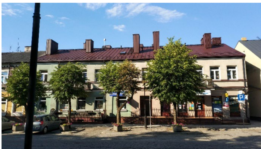
Zdjęcie 3. Wyremontowany dach budynku przy Rynku Zygmunta Augusta 15.
