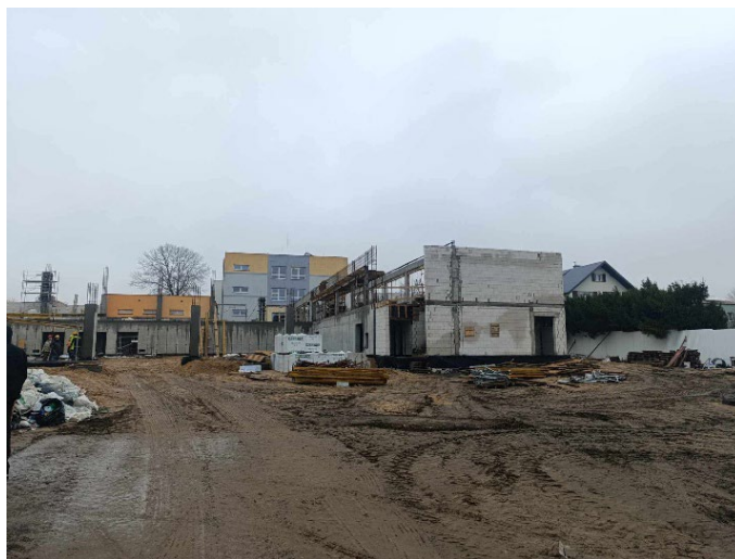
Zdjęcie 12. Prace przy budowie sali gimnastycznej przy Szkole Podstawowej nr 2 w Augustowie.
